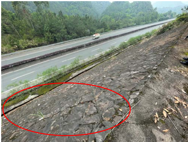
图 4 墙面裂缝
